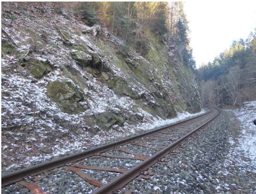
Pohled ze začátku úseku. Po odstranění vegetace a očištění bude skal. stěna v geotechnikem vytypovaných partiích zajištěna lokálním kotvením.
